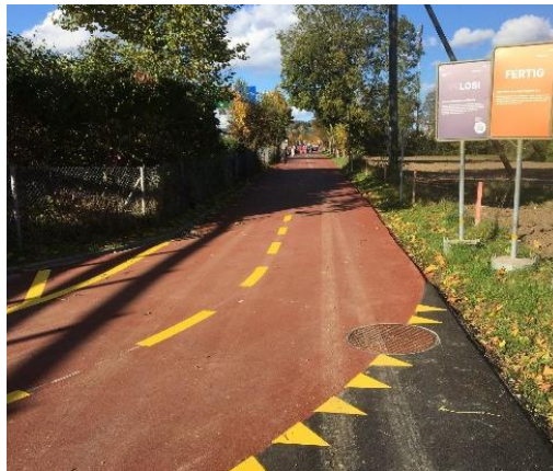
Abbildung 42: Massnahmen für eine höhere Sichtbarkeit der Veloinfrastruktur, Beispiele aus Winterthur (links: FGSO-Bänder, rechts Belageinfärbung)
