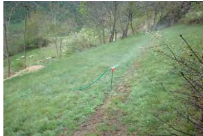
Links: Fest installierte Bewässerungsanlage in einer Felsensteppe (Ausserberg, VS).
