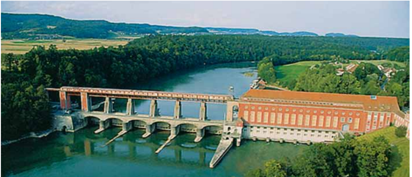
Abb. 2 Kraftwerk Eglisau-Glattfelden; Quelle: axpo
