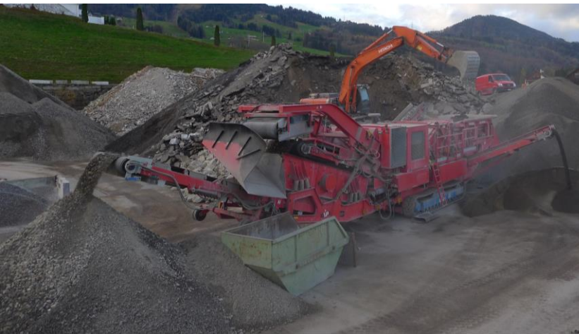
Abb. 11: Aufbereitungsanlagen für Bauabfälle müssen die Qualität der Recyclingbaustoffe sowie andere Umweltanforderungen einhalten (Lärm, Staub, Entwässerung).
