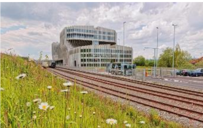
Abb. 2: Kehrrechtverbrennungsanlage Renergia (Foto renergia.ch)
