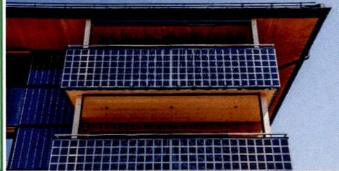
**Fahrwangen/AG:** Die Min.P/PEB-Sanierung des Mehrfamilienhauses (MFH) reduziert den Gesamtenergieverbrauch um 82%, von 138'000 kWh/a auf 25'000 kWh/a. Die PV-Dach- und Fassadenanlagen generieren 78'000 kWh/a mit einem Solarstromüberschuss von 53'000 kWh/a oder 215%.
