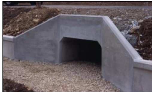
Abbildung 47: Amphibienleitsystem mit Kleintierdurchlass, alle 50 - 100 m
