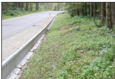
Abbildung 47: Amphibienleitsystem mit Kleintierdurchlass, alle 50 - 100 m
