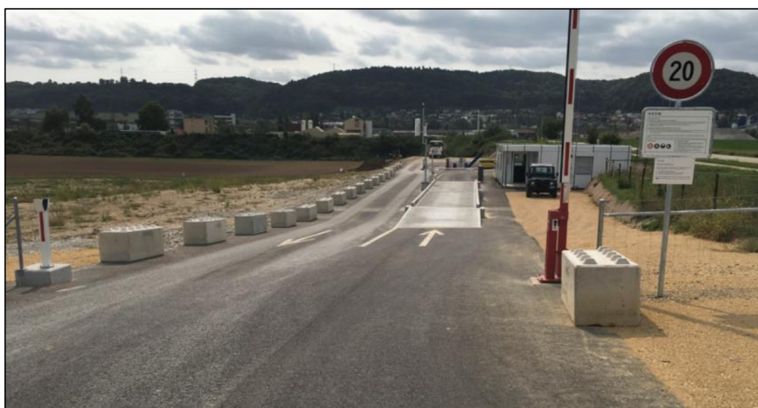
Abbildung 3: Ein-/Ausgangsbereiche Aushubdeponie Sisslerfeld mit Betriebsgebäude, Waage und Radwaschanlage
