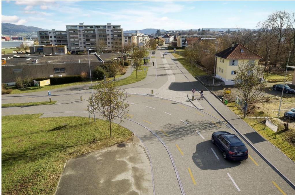
Der Gehweg wird auf der Südseite durchgehend mit mindestens 2,00 m Breite geführt. Auf der Nordseite wird der Gehweg vom Rössliplatz bis zur Pfaffnernbrücke ausgebildet, anschliessend wieder vom Parkweg durchgehend bis zum Anschluss Grüthgässli. Die Breite auf der Nordseite beträgt wo möglich 2,00 m, lokal muss der Gehweg jedoch leicht schmaler geführt werden. Die bestehende Situation wird vor allem im Bereich Gemeindehaus bis Klinik Villa im Park deutlich verbessert.
