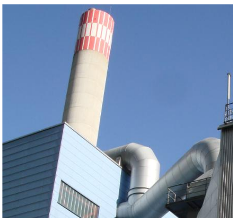
Abb. 1: Kehrichtverbrennungsanlage Linthgebiet (Foto AfU)
