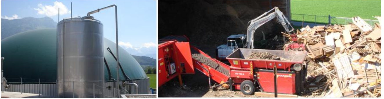
Abb. 7: Biogasanlage im Talkessel Schwyz und Aufbereitungsplatz für Altholz (Foto AfU)
