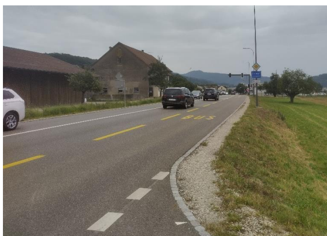
Busspur vor Dosierungsanlage: Die Lichtsignalanlage ermöglicht das Zurückhalten des Staus ausserhalb des Siedlungsgebiets und die Priorisierung der Busse Richtung Baden.
