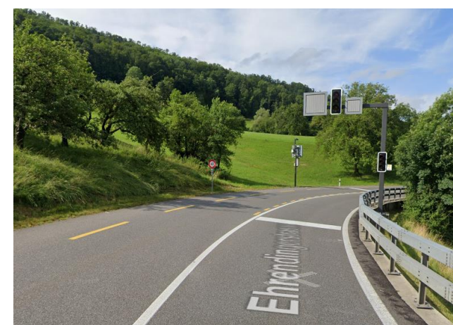
Das Lichtsignal dosiert den Verkehr Richtung Ennetbaden und dient gleichzeitig als Buspriorisierungsmassnahme. (Quelle Foto: Google Streetview)
