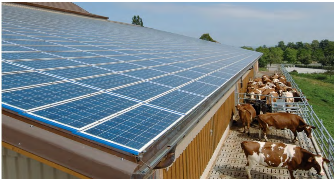
Abb. 10: Landwirtschaftsbetrieb in Barberêche/FR mit 110 kWp PV-Anlage produzierte von 2005-2016 durchschnittlich 125'000 kWh/a; nicht 105'000 kWh/a wie 2006 publiziert (Bestätigt von Groupe E/FR, Schweizer Solarpreis 2006, S. 32/33; vgl. Abb. 1b).
