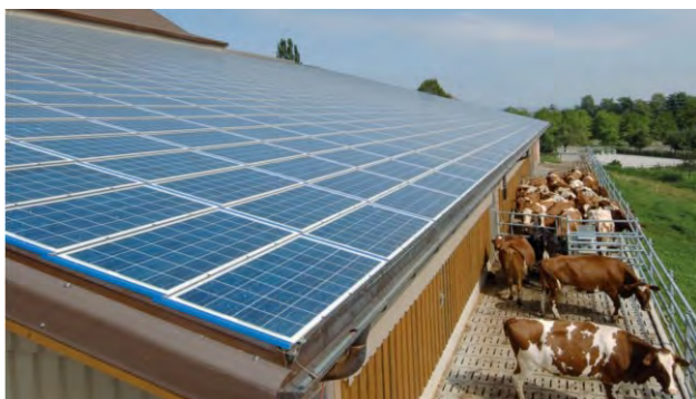
Abb. 3: Landwirtschaftsbetrieb in Barberêche/FR mit 110 kWp PV-Anlage produzierte von 2005-2016 durchschnittlich 125'000 kWh/a; nicht 105'000 kWh/a wie 2006 publiziert (Bestätigt von Groupe E/FR, Schweizer Solarpreis 2006, S. 32/33; vgl. Abb. 1b).
