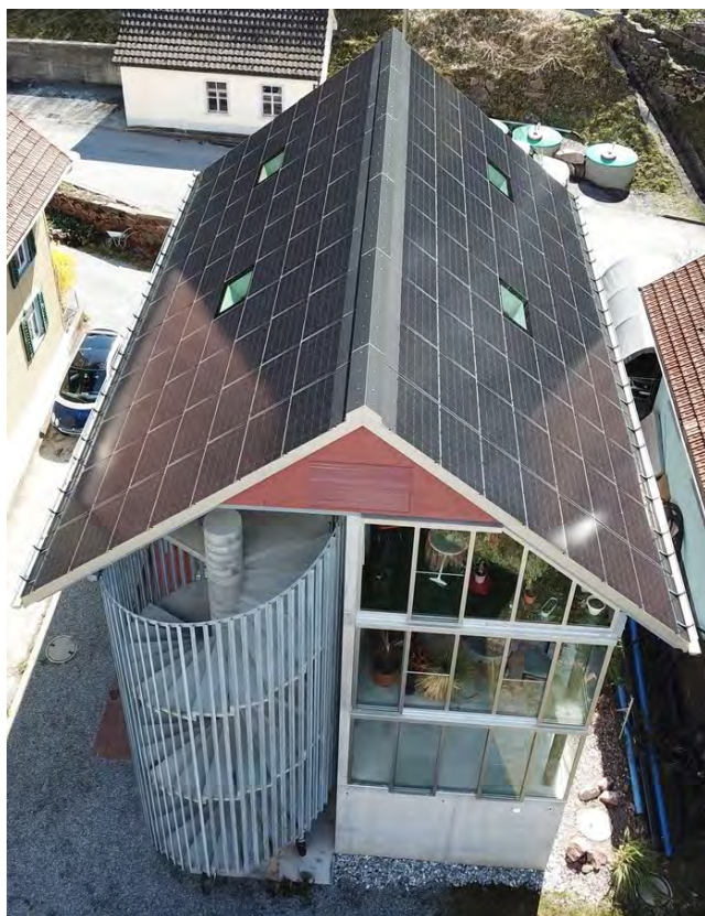
Abb. 12: PEB MFH Sanierung in Murg/SG (PEB Solarpreis 2019/3 E-Autos jährlich)
