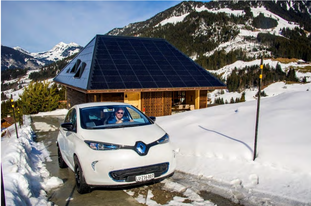
Abb. 15: PEB Sieber in Sörenberg/LU (PEB-Solarpreis 2015/20 E-Autos jährlich) Gesamtenergiebedarf: 9'020 kWh/a (100%) Solarstromüberschuss: 34'803 kWh/a (386%) Eigenenergieversorgung: 43'823 kWh/a (486%)
