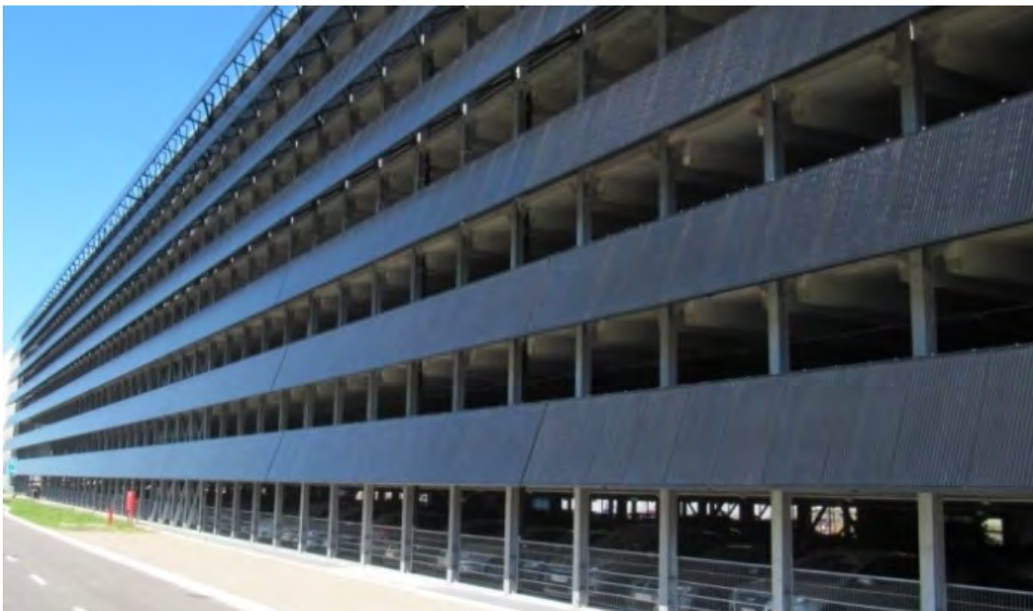
Abb. 23: Der Fassadenstromertrag des solaren Parkhauses Hoffmann-La Roche beträgt 140.2 kWh/m 2 a oder 95.7% des Dachsolarstromertrages von 146.5 kWh/m 2 a – ein Weltrekord (Werte bestätigt durch AEW Energie AG am 22.06.2017, Schweizer Solarpreis 2017, S. 90/91/378 E-Autos jährlich).
