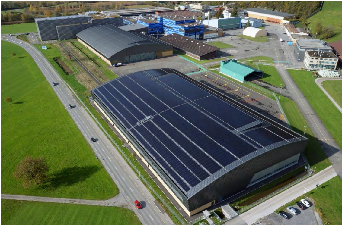
Abb. 18: PEB Pilatus Flugzeugwerke AG in Stans/NW (Norman Foster Solarpreis 2018/90 E-Autos jährlich) Gesamtenergiebedarf: 966'666 kWh/a (100%) Solarstromüberschuss: 125'828 kWh/a (14%) Eigenenergieversorgung: 1'092'494 kWh/a (114%)
