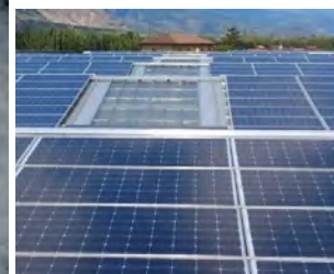
Abb. 10: Solstis SA et Joseph Carron SA ont inauguré la plus grande installation photovoltaïque du Valais, sur la toiture du dépôt d'engins à Saxon (PEB Diplom, Schweizer Solarpreis 2013/557 E-Autos jährlich) Gesamtenergiebedarf: 225'265 kWh/a (100%) Solarstromüberschuss: 779'455 kWh/a (346%) Eigenenergieversorgung: 1'004'720 kWh/a (446%)
