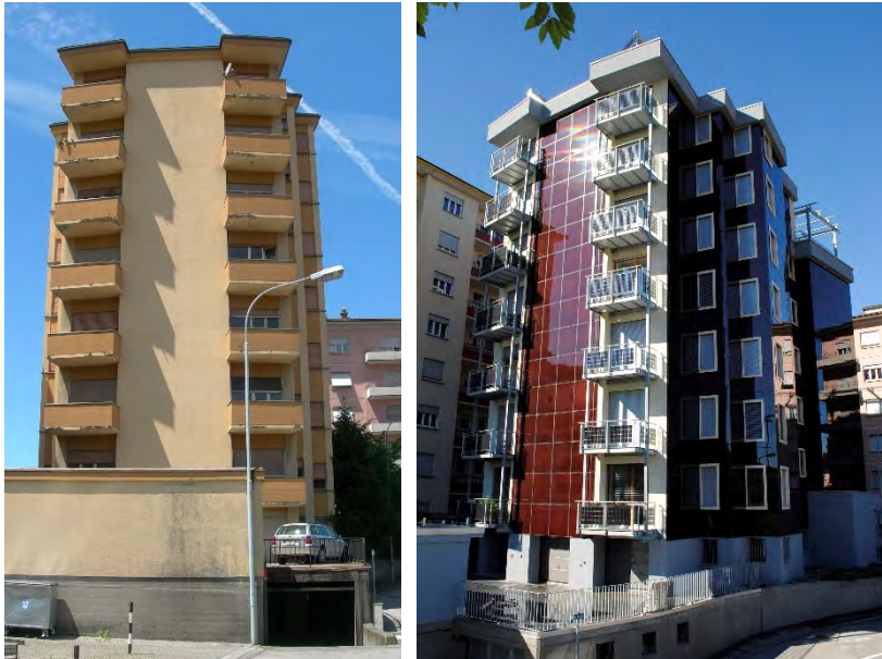
Abb. 4: 114%-PEB-MFH Palazzo Positivo Gasser von 1995 vor und nach der Sanierung 2018. Das achtstöckige MFH reduzierte den Energiebedarf von 502'900 kWh/a um 88% auf 62'500 kWh/a. Die PV Dach- und Fassadenanlagen generieren gut 71'100 kWh/a, die Eigenenergieversorgung beträgt 114% (Schweizer Solarpreis 2014/7 E-Autos jährlich).
