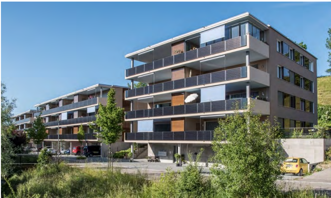
Abb. 3: PEB Siedlung Tobel mit 32 Wohnungen (Europ. und Schweizer Norman Foster-PEB Solarpreis 2019/77 E-Autos j.) Energiebedarf vor San.: 133'320 kWh/a (100%) Eigenenergieversorgung: 236'300 kWh/a (182%) Energiebedarf nach San.: 129'500 kWh/a (97%) Solarstromüberschuss: 106'800 kWh/a (82%)
