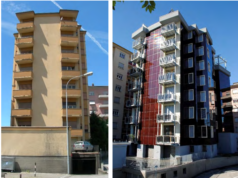
Abb. 7: 114%-PEB-MFH Palazzo Positivo Gasser von 1995 vor und nach der Sanierung 2018. Das achtstöckige MFH reduzierte den Energiebedarf von 502'900 kWh/a um 88% auf 62'500 kWh/a. Die PV Dach- und Fassadenanlagen generieren gut 71'100 kWh/a, die Eigenenergieversorgung beträgt 114% (Schweizer Solarpreis 2014/7 E-Autos jährlich).
