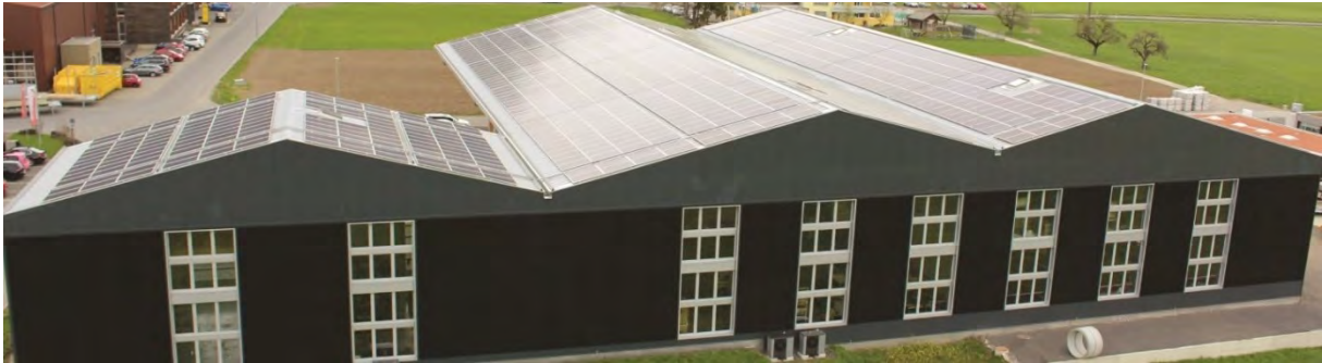
Abb. 22: Ansicht und Energiebedarf des Energieparks Gams in Gams/SG. Der produzierte Solarstrom wird vor allem von der Eigenverbrauchsgemeinschaft genutzt, die 12 Firmen umfasst. Dieser vorbildliche PlusEnergie-Gewerbebau erhielt den Solarpreis 2018 (Werte bestätigt von der Elektro Gams Genossenschaft am 06.07.2018, Tel. 081 750 39 20; Schweiz. Solarpreis 2018, S. 36/37/249 E-Mobile jährlich).
