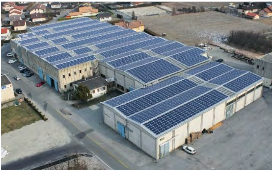
Abb. 19: Solstis SA et Joseph Carron SA ont inauguré la plus grande installation photovoltaïque du Valais, sur la toiture du dépôt d'engins à Saxon (PEB Diplom, Schweizer Solarpreis 2013/557 E-Autos jährlich) Gesamtenergiebedarf: 225'265 kWh/a (100%) Solarstromüberschuss: 779'455 kWh/a (346%) Eigenenergieversorgung: 1'004'720 kWh/a (446%)
