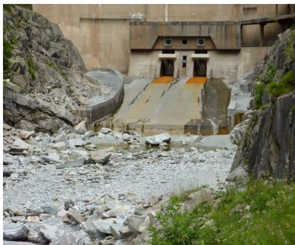
Abb. 6+7: Die „Restwasserstrecke“ der Massa unterhalb des Stausees Gibidum/VS weist „Null Restwasser“ auf. Das Schmelzwasser des Aletschgletschers wird gänzlich gesammelt und turbinert. Der Bach und seine Lebewesen sind schwer beeinträchtigt. (Fotos: SGS)
