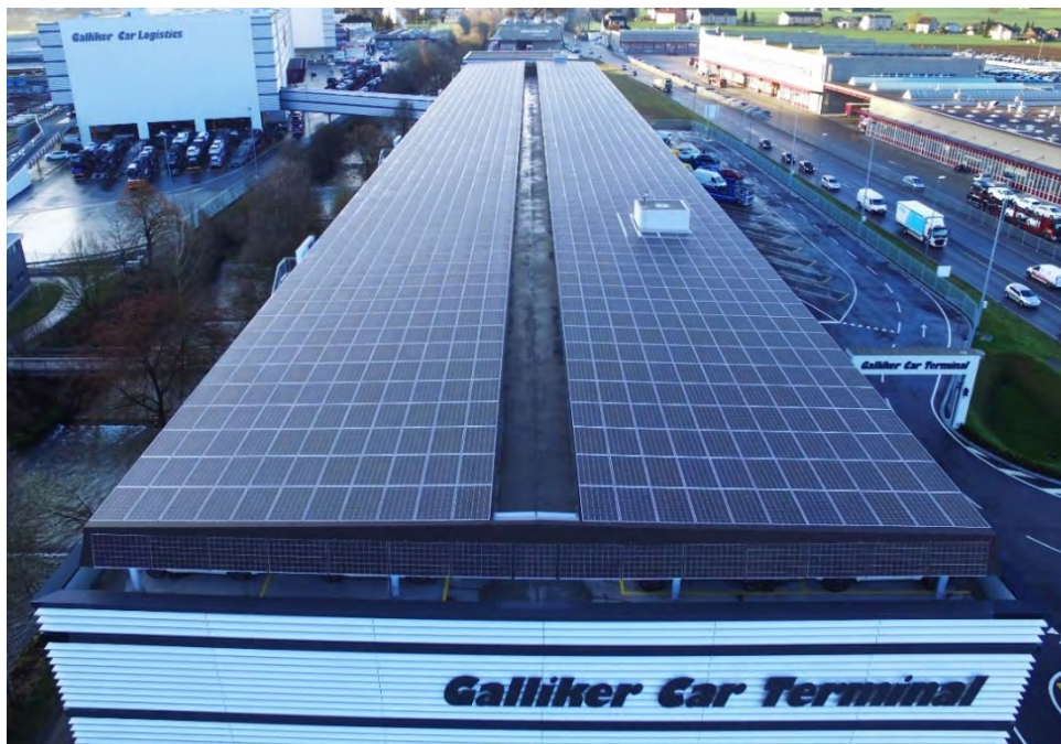
Abb. 20: PEB Galliker Transport (PEB-Solarpreis 2017/148 E-Autos jährlich) Gesamtenergiebedarf: 314'136 kWh/a (100%) Solarstromüberschuss: 206'684 kWh/a (66%) Eigenenergieversorgung: 520'820 kWh/a (166%)
