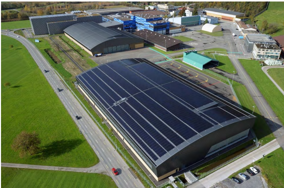
Abb. 9: PEB Pilatus Flugwerke AG in Stans/NW (Norman Foster Solarpreis 2018/90 E-Autos jährlich) Gesamtenergiebedarf: 966'666 kWh/a (100%) Solarstromüberschuss: 125'828 kWh/a (14%) Eigenenergieversorgung: 1'092'494 kWh/a (114%)
