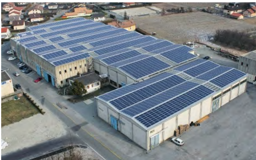
Abb. 10: Solstis SA et Joseph Carron SA ont inauguré la plus grande installation photovoltaïque du Valais, sur la toiture du dépôt d'engins à Saxon (PEB Diplom, Schweizer Solarpreis 2013/557 E-Autos jährlich) Gesamtenergiebedarf: 225'265 kWh/a (100%) Solarstromüberschuss: 779'455 kWh/a (346%) Eigenenergieversorgung: 1'004'720 kWh/a (446%)
