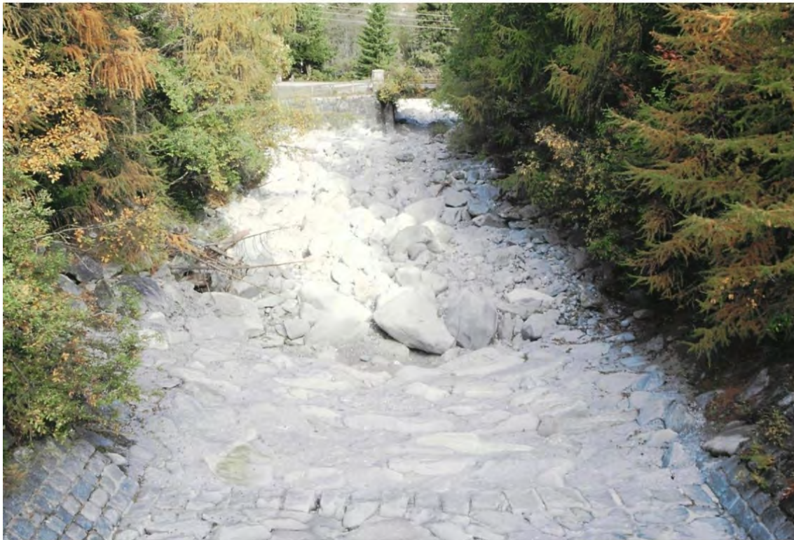
Abb. 21: Surettabach/GR oberhalb Andeer von den KHR/NOK/AXPO trockengelegt (Bild SGS, Okt 2008)
