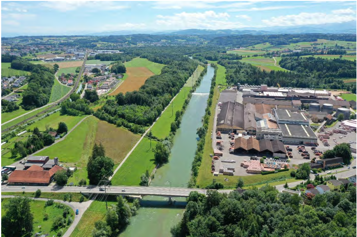
Abschnittsweise ist der Flusslauf wie hier bei Bürglen begradigt und eingefasst.
